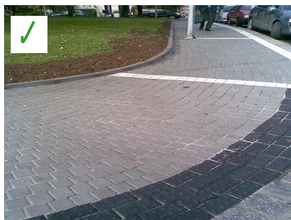
Materiál schválený pro hmatové prvky, správné je i barevně kontrastní řešení. Detail označení nebezpečného prostoru, místo pro přecházení.
