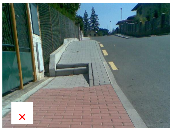
bariérový chodník s vyrovnávacími stupni a s nevyhovující šířkou rampy (cca 40 cm), chybí zábradlí u rampy a varovný pás u vjezdu
