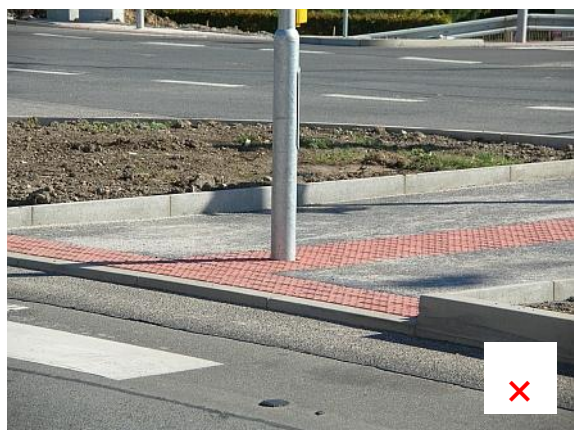
rozdíl výšek cca 50 mm u středového ostrůvku pro pěší (rozpor s vyhl. č. 369/2001 Sb.)
