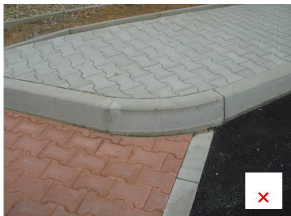
Nevhodné řešení: bariérový chodník bez rampy
