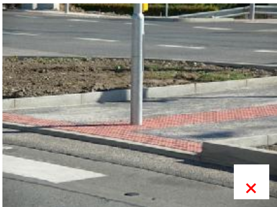
rozdíl výšek cca 50 mm u středového ostrůvku pro pěší (rozpor s vyhl. č. 398/2009 Sb.)
